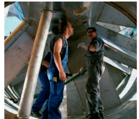
Montage du malaxeur
